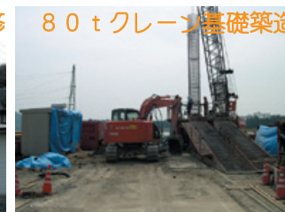
尾道市山波町 尾道造船 大型クレーン基礎
