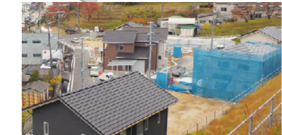
新築住宅続々完成!
